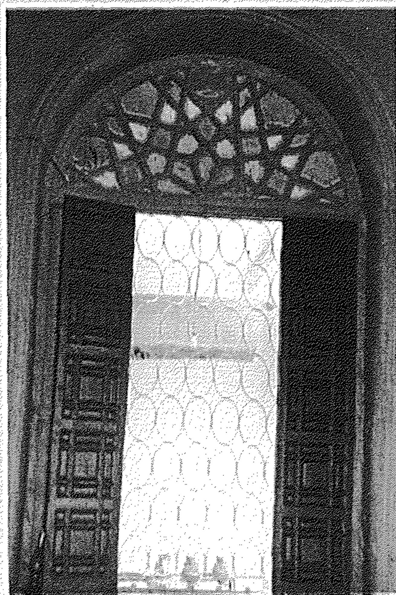
لوحة رقم ( ١٩٥ ) : الشباك الكبير بالجدار الجنوبي الغربي بمسجد الوكيل بسمخراط
